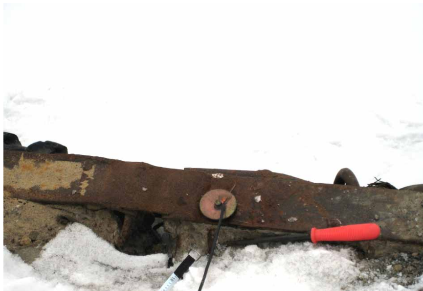
Рис. 1. Присоединение провода к оголовку железобетонной сваи
