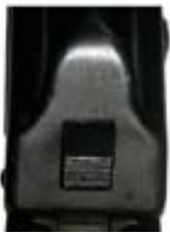
Фото 25. Заводской номер оружия, нанесенный в армейских мастерских на крышку ствольной коробки автомата АКМ.
