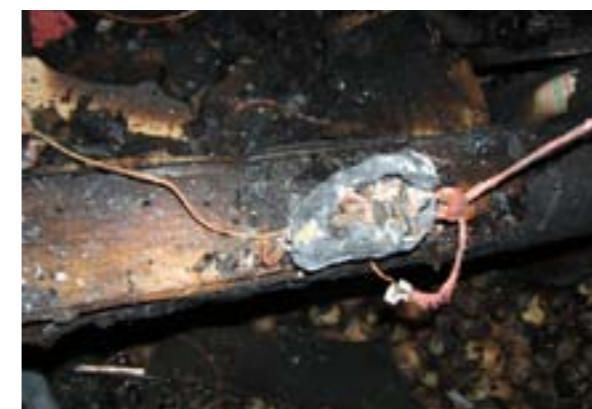
Фото 14. Вид сверху части кресла и пола рядом с ним. На левом подлокотнике (1) кресла лежит корпус УЗО (2) с выведенными с одной стороны двумя оголенными жилами проводов (3) для подсоединения в районе панели электросчетчика, с другой стороны – фрагменты двух медных однопроволочных проводников с оплавлением (4), вызванным КЗ
