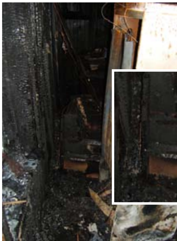
Фото 12. Вид от центра жилой комнаты и рядом с межоконным простенком в сторону стены с дверным проемом, дающий представление о расположении поврежденного пожаром морозильника (1) относительно левого окна (2), находящегося за холодильным прибором, деревянной стойки-бруса (3), кресла (4), стоящего справа от морозильника и обращенного спинкой к межоконному простенку. Пластиковые ящики-поддоны при пожаре не догорели, их остатки (5) выпали на пол перед морозильником
