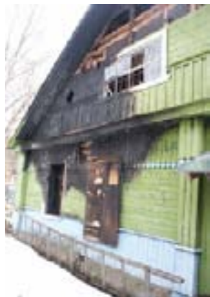
Фото 1. Снаружи термические повреждения наблюдаются только у стены дома, обращенной в сторону кладбища. Вертикальная ось делит зону поражения примерно на две симметричные части, что свидетельствует о начале пожара внутри в районе середины межоконного простенка
