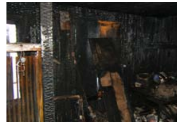
Фото 13. Вид части жилой комнаты в районе стены с двумя окнами и угла, образованного этой стеной и стеной (1) справа (стеной с окном, где сохранилось остекление). Видно расположение корпуса морозильника (2) относительно левого окна (3), закрытого обгоревшими панелями от шкафа (4) правого окна и кресла (5), а также стола (6) с книгами относительно кресла. Справа от кресла и вплотную к стене расположена куча картошки (7). На правом подлокотнике кресла лежит корпус УЗО (8) с проводом, идущим от него в направлении металлической панели электрощитка (9), на которой был установлен электросчетчик
