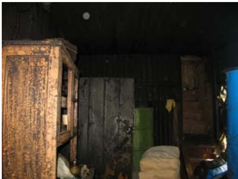
Фото 2. Вид прихожей, граничащей по левой стене с жилой комнатой, со стороны входной двери. Поверхность двери (1), обращенная в закрытом состоянии в сторону жилой комнаты, обгорела не полностью – с уровня ниже уровня ручки. Лестница (2), ведущая в мансарду, пожаром практически не повреждена
