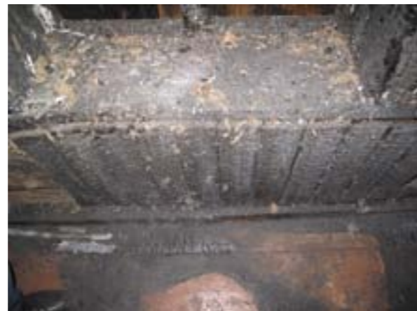
Фото 10. Вид части жилой комнаты перед левым окном в стене, обращенной в сторону кладбища. Под окном доски обшивки стены и плинтус обуглены. Видны участки пола, не подвергшиеся действию высокой температуры (краска на досках сохранилась)
